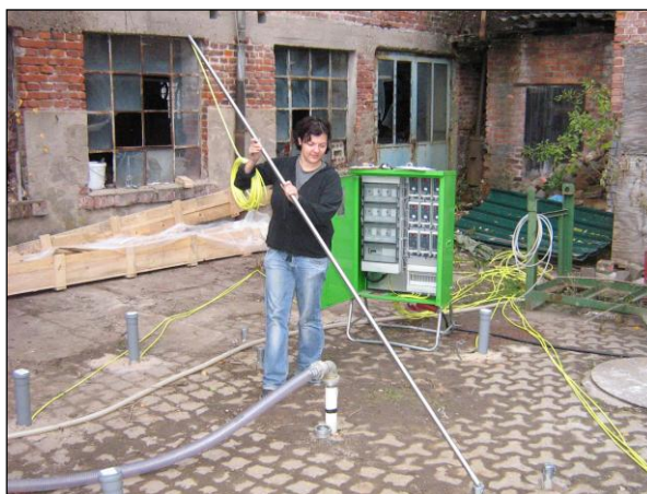
Einrichtung des THERIS-Verfahrens (Montage der Heizsonden)
