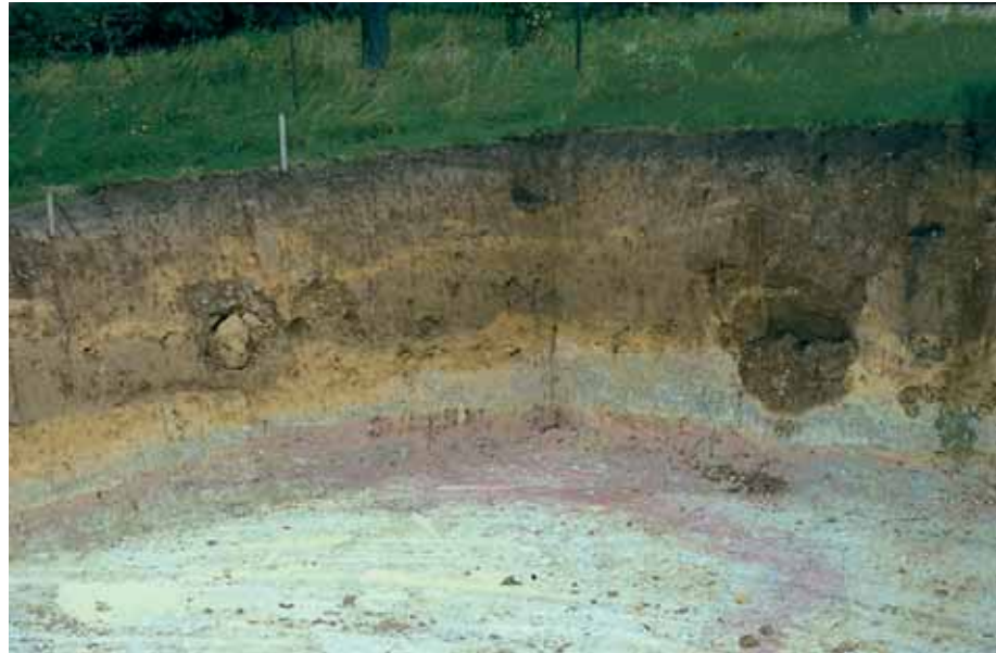
Abb. 3. Brandungsblöcke in einer Baugrube am Südrand von Langenhain. Im tiefsten Teil der Baugrube ist das violettrote Rotliegend angeschnitten. Darüber liegt gebleichtes (graues) Rotliegend-Substrat, das verspült ist. Es wird von gelblichem lehmigem Kies, dem Hofheimer Kies, überlagert, der im ehemaligen Küstenbereich gebildet wurde. In ihm liegen große Blöcke aus Quarzgestein. Rechts im Bild ist eine mit dunklem Lehm ausgekleidete Hohlform zu erkennen, aus der der Bagger einen großen Block entfernt hat. Links im Bild wurde ein etwas kleinerer Block beim Ausbaggern nach oben in den viel jüngeren braunen Lösslehm gedrückt.
