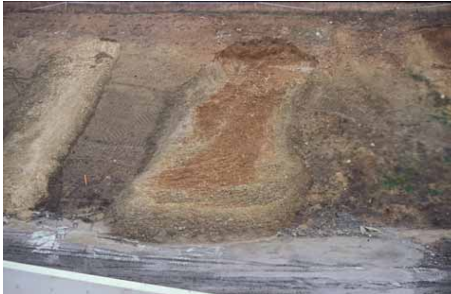
Abb. 8. Ausfließender Mergel in der ICE-Trasse bei Wallau. Der Mergelbrei fließt zungenförmig über das bereits betonierete Gleisbett hinweg. Über dem grauen Mergel liegt rostfarbiger kaltzeitlicher Kies, in dem sich Grundwasser sammelt, das den Mergel vernässt und ausfließen lässt.
